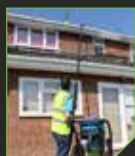
PULIZIA IN ALTEZZA
